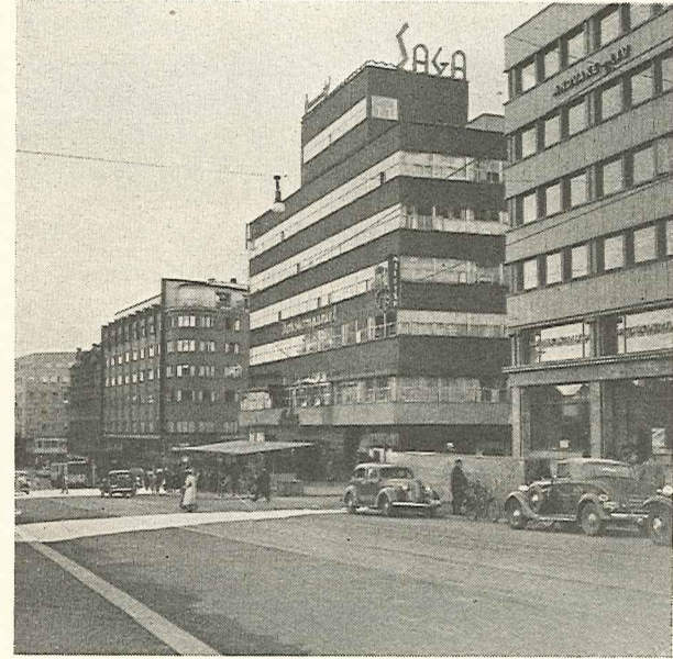
Fig. 6. Betonhusene i Karl Johans øvre Ende.
