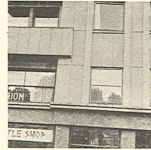
Fig. 14. Huset tilhøjre paa Fig. 6. Stueetagen er beklædt med Marmorplader, derover Mineralitpuds.
